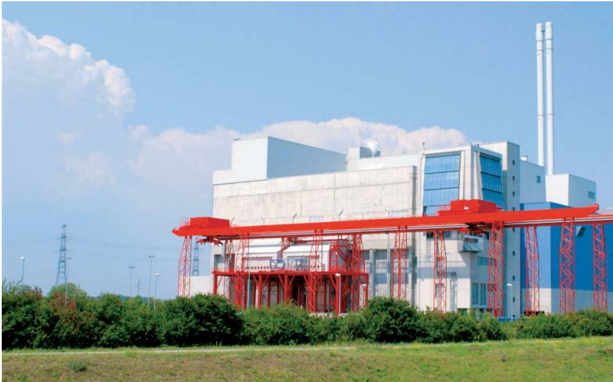
Blick auf die AVN-Anlage von Süden. Alle Gebäude und Anlagenteile sind fertiggestellt und funktionstüchtig. Im Vordergrund die rote Kranbahn, die zur automatischen Entladung der Bahncontainer bereitsteht.
