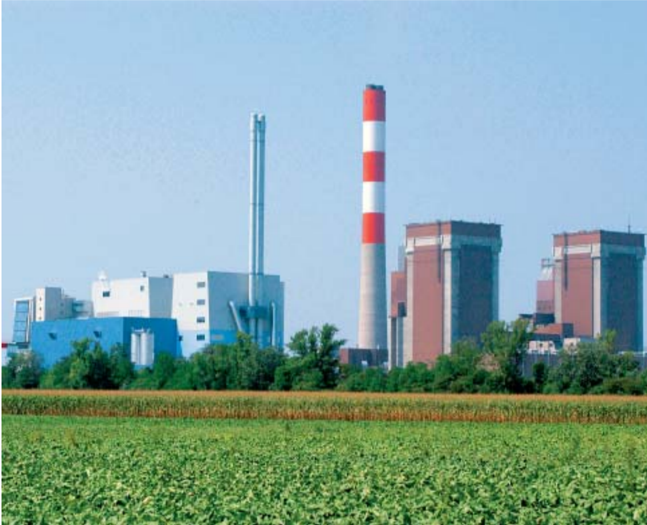
Weltweit einzigartig ist das Energiezusammenspiel einer Müllverbrennungsanlage mit einem kalorischen Kraftwerk. Es besteht aus der Erzeugung von Dampf aus Müll in der AVN-Anlage und seiner Umwandlung zu Strom im Kraftwerk Dürnrohr.
