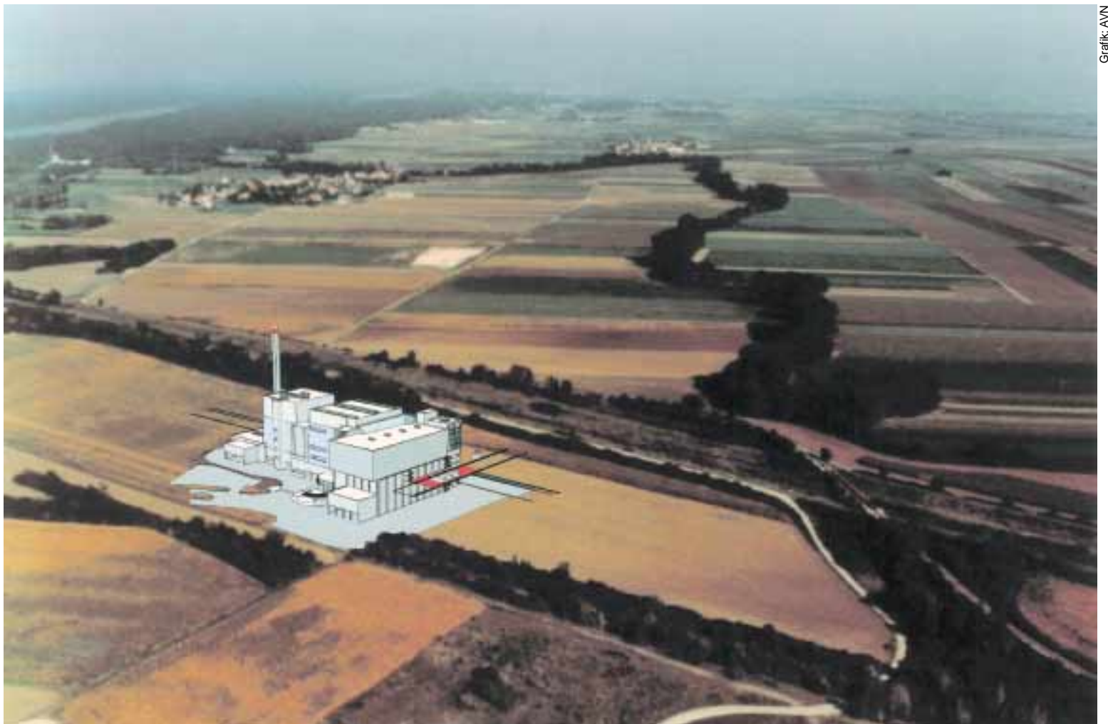
Noch steht das Getreide am AVN-Grundstück und das Bild ist eine Photomontage: Anfang Juli 2001 wird mit dem Bau begonnen
